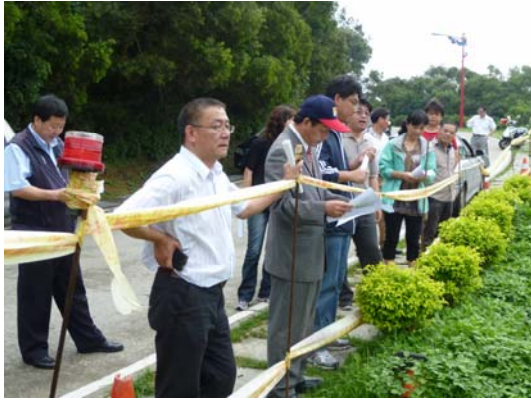
考察四維集水池邊坡復建工程
