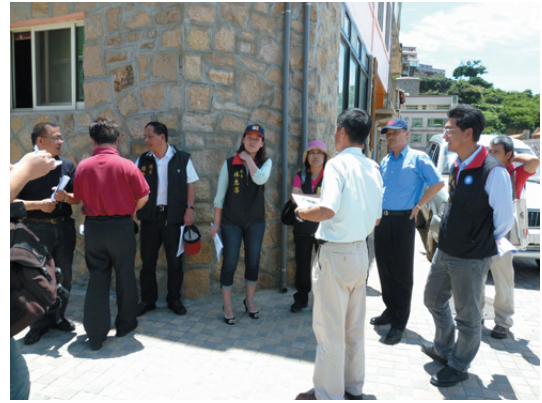
考察津沙村污水施作管路工程
