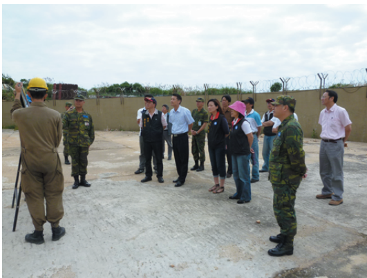
考察復興村油池坑道坍方
