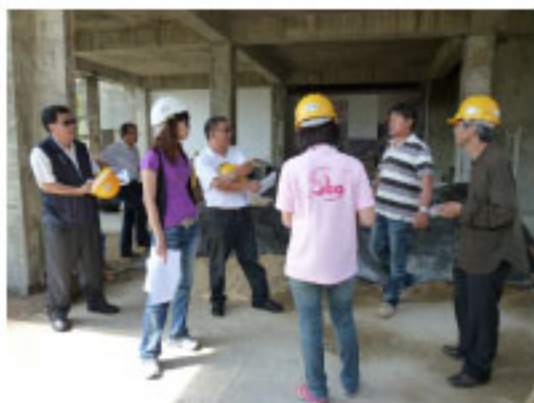
考察社教館附屬圖書館整建工程
