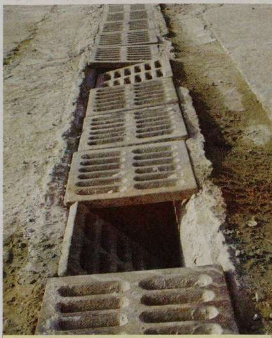
北竿工程多項同時進行，水溝蓋破損率高，鄉公所呼籲民眾一經發現，應立即向鄉公所反映，以便及時更換。
