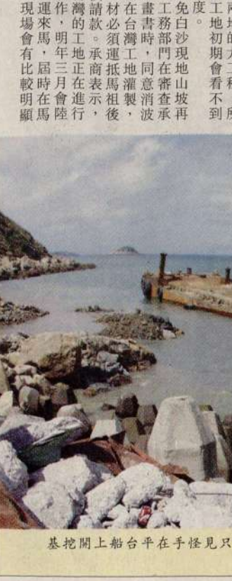
沙頭碼頭二期擴建工程目前仍見怪手在開挖地基。
