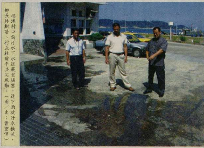
福澳村人口前污水下水道嚴重堵塞，逢下雨就污水橫流，鄉長林樹清、村長林爾平共同現勘。(圖/文：曹重偉)
