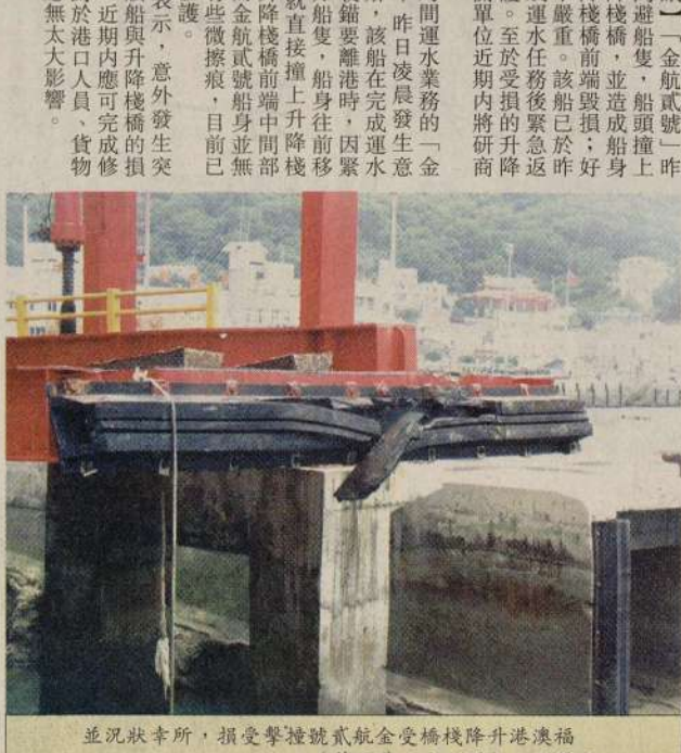
並況狀幸所，損受擊撞號航金受橋棧降升港澳福 (偉重曹：文/圖)。重嚴不
