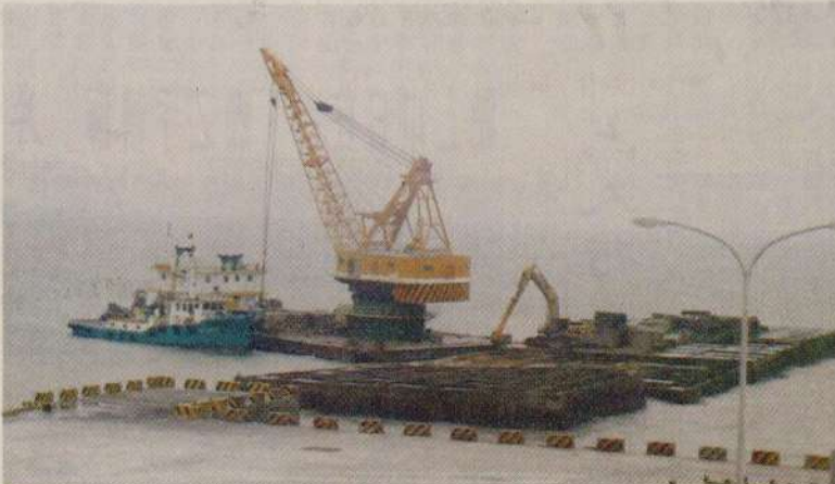
北竿新建航站工程需大量土石方，預計今年七月完工。
