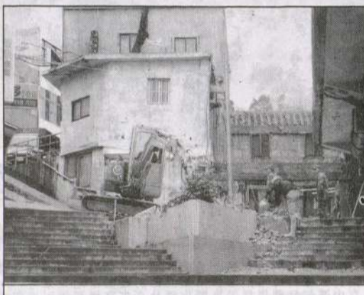
東引南澳中路水泥路拆完後，涼亭將建新。圖為：東引南澳中路水泥路拆完後，涼亭將建新。
