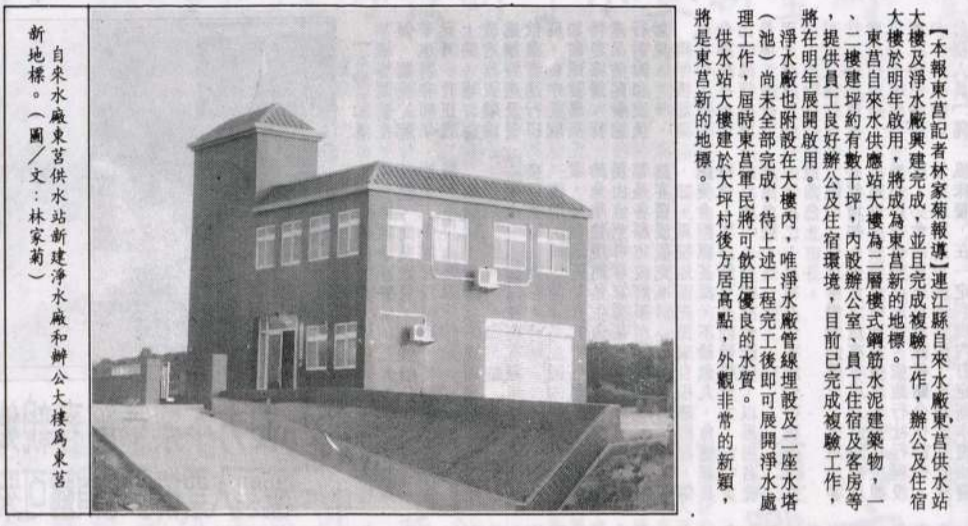
東莒新供水站大樓完成，並完成檢驗工作，辦公及住宿大樓自來水供應站大樓為二層樓式鋼筋水泥建築，內設辦公室、員工住宿及客房等，提供員工良好辦公及住宿環境，目前已完成檢驗工作，將在明年展開啟用。
