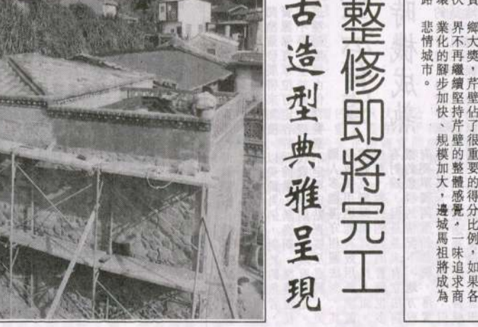
西莒田澳首棟古厝整修即將完工 老屋重獲新生 復古造型典雅呈現
