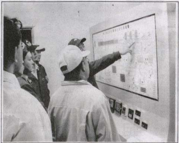
東引海淡廠試運轉情形。圖為廠內設備。
