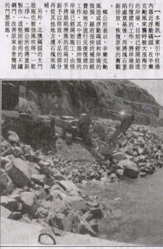
東引中港進岸堤修復工程，公所全力恢復舊觀。
