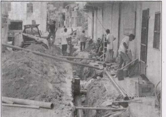
東莒大坪水下水道工程積極趕工，影響附近居民生活，廠商盼共體時艱。
