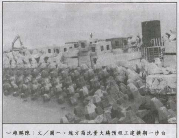
—白沙碼頭擴建工程預鑄沈箱方塊即將完成
