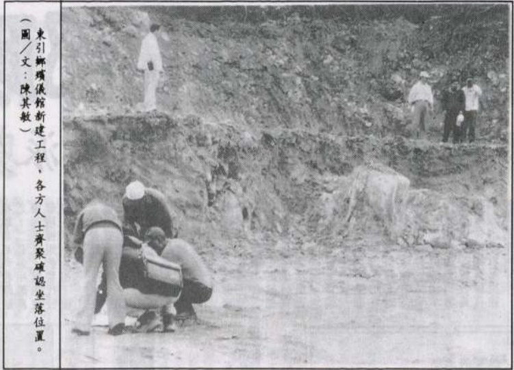
東引殯儀館新建工程，各方人士齊聚現場坐落位置。
