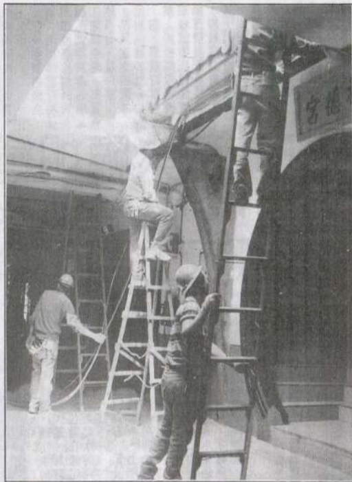
台電馬祖區處為改善莒光地區供電安全及品質，更新用戶接線工程。
