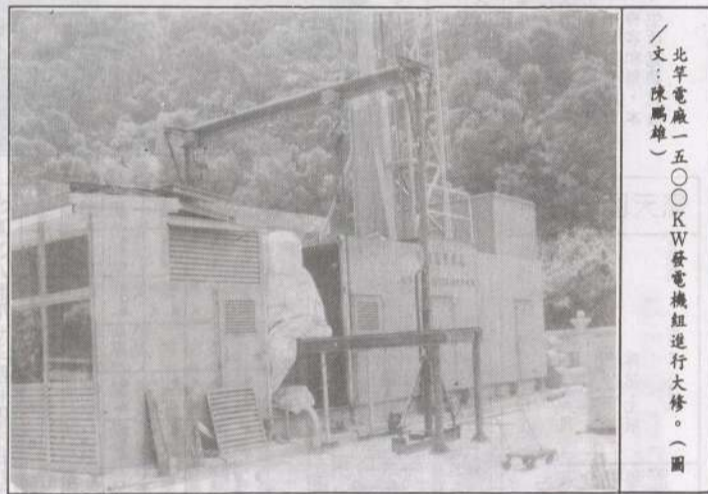
北竿電廠一五〇〇KW發電機組進行大修。(圖文：陳國雄)
