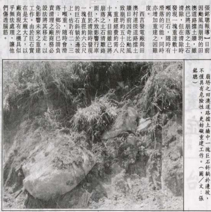
田澳崩落土牆，體積龐大，難於處理。崩落之田澳土牆，土質鬆軟，且因連日大雨，土質鬆動，致發生崩落。崩落之土牆，土質鬆軟，且因連日大雨，土質鬆動，致發生崩落。崩落之土牆，土質鬆軟，且因連日大雨，土質鬆動，致發生崩落。
