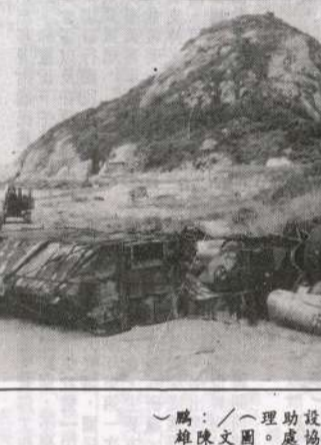
圖為A廠拌AC材料廠建設現場，由國工局、太平洋建設公司共同建設。
