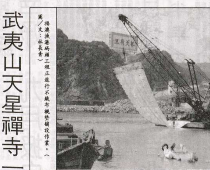
福澳漁港碼頭工程正進行不織布圍堰拋石作業。(圖/文：林長青)
