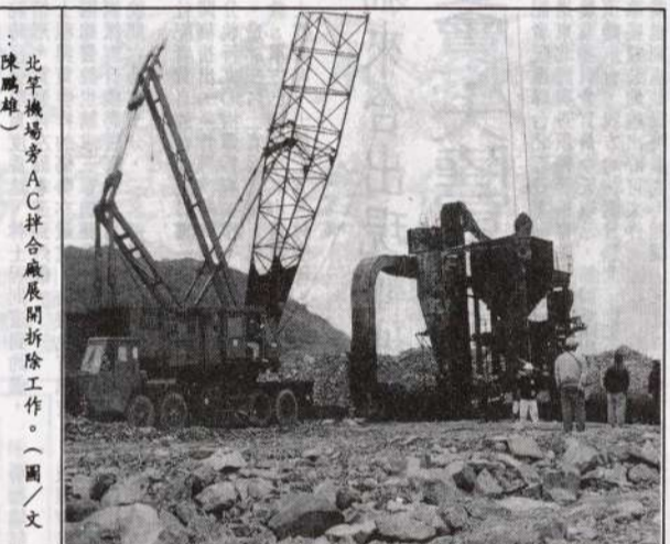
北竿機場旁A/C拌合廠一週內完成拆除
