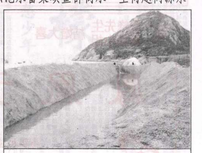
一線鳴陳：文/圖一。用備池水蓄型大築渠程工移東
