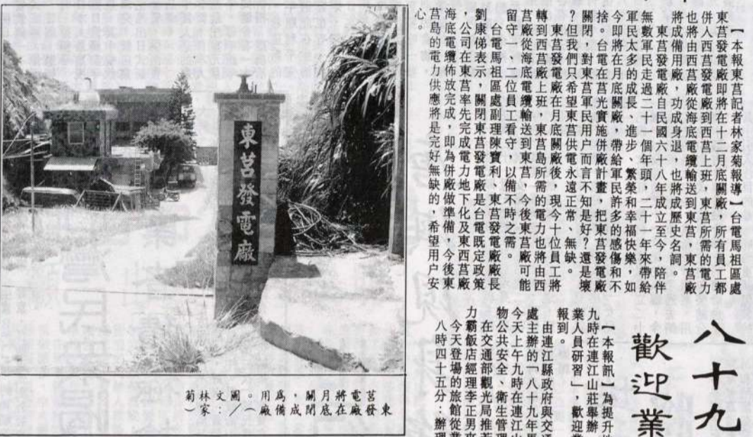
東莒發電廠併廠計畫，即將完成。圖為東莒發電廠廠區。
