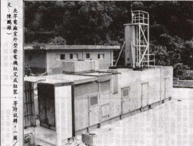
北竿電廠室外型發電機組完成組裝，等待試轉。
