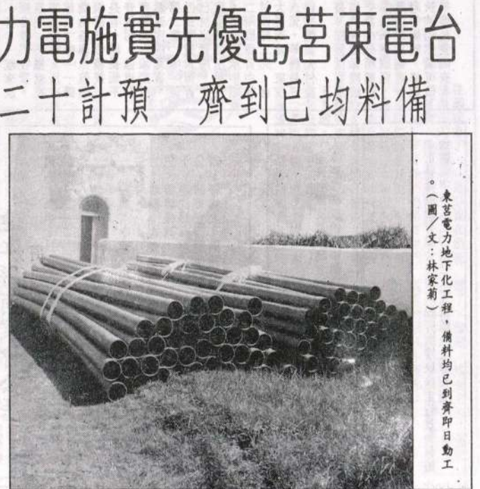
台東莒島先實施電力地下化工程，備料均已到齊即日動工。
