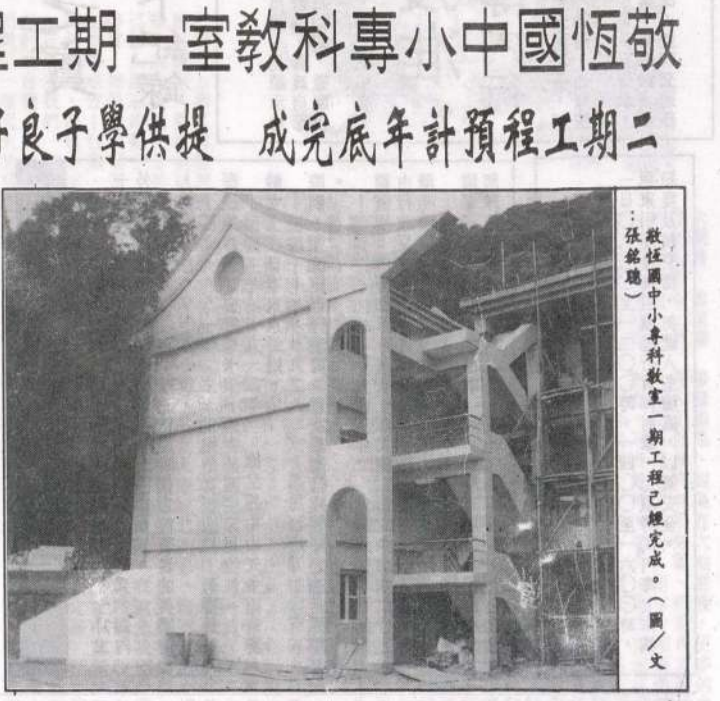
敬恆國小專科教室一期工程已竣工。 (圖/文：張銘聰)
