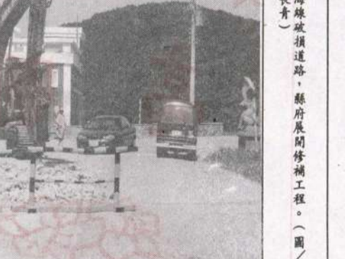
南竿海線破損道路，縣府展開補修工程。(圖/文：林長青)
