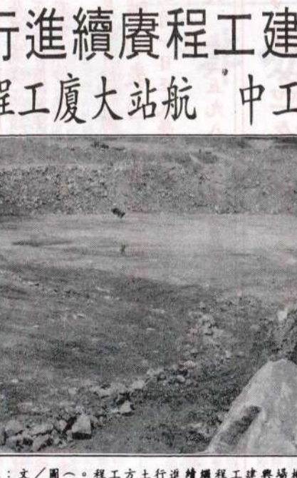
南竿機場興建工程進度持續 大站航廈工程進展 (圖/文林長青)
