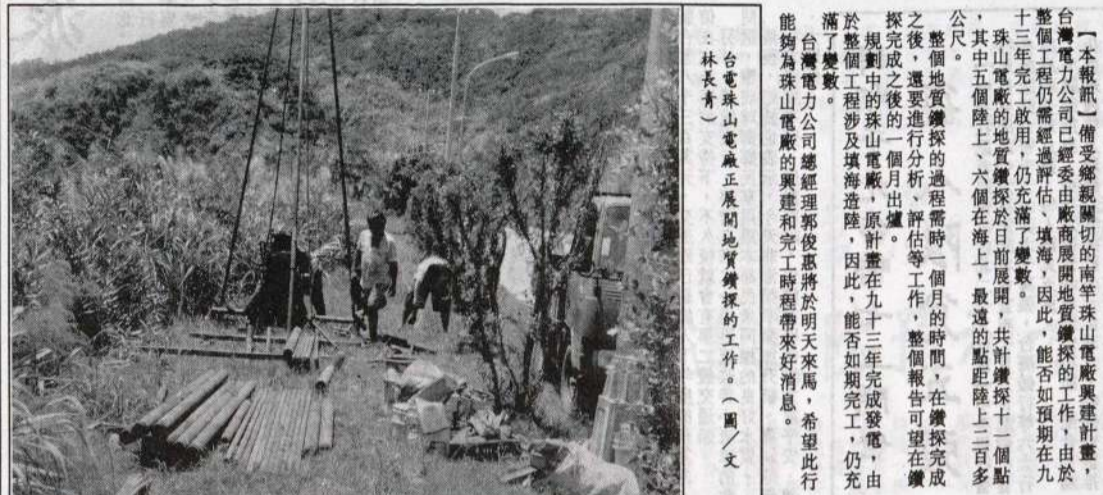
台電珠山電廠正在展地質鑽探的工作。(圖/文林長青)
