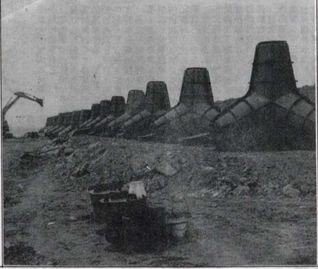
跑道東移工程正進行消波塊生產前置作業。(圖/文：陳曉輝)
