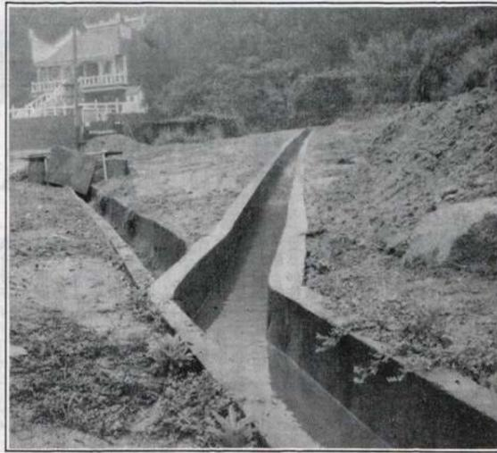
【本報訊】北竿環島北路截流系統靈骨塔集水池附近工程，來自山溝的大量雨水經導溝順著地形流入芹壁集水池。這項工程是全段截流系統中之唯一運用地形重力流的概念，將成為日後截流改善的重要方向。
