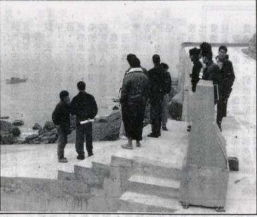
建設局建設科科長陳國棟與各級民代現地會勘，聽取地方建言，規劃多種可行方案，並公開說明完成定案。
