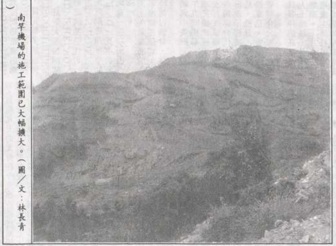
南竿機場的施工程度已大幅擴大。(圖/文：林長青)
