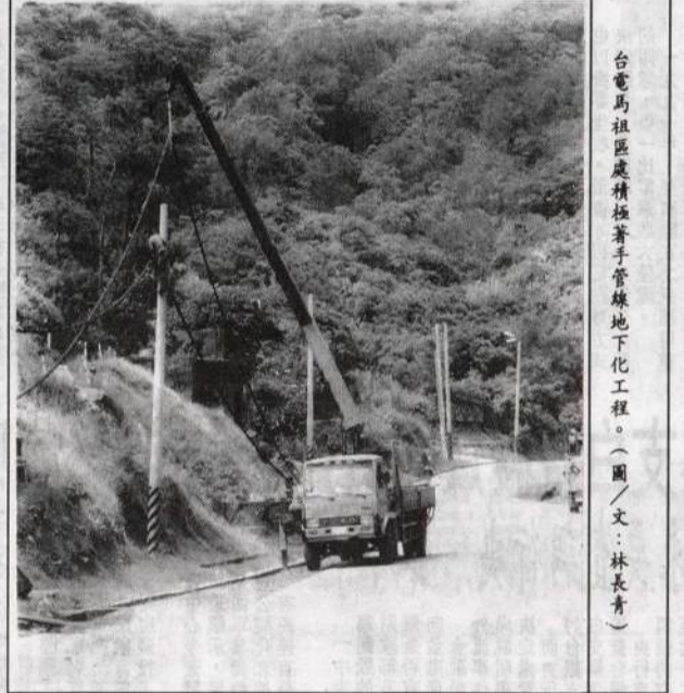
台電馬祖區處積極推動管線地下化工程。(圖/文：林長青)
