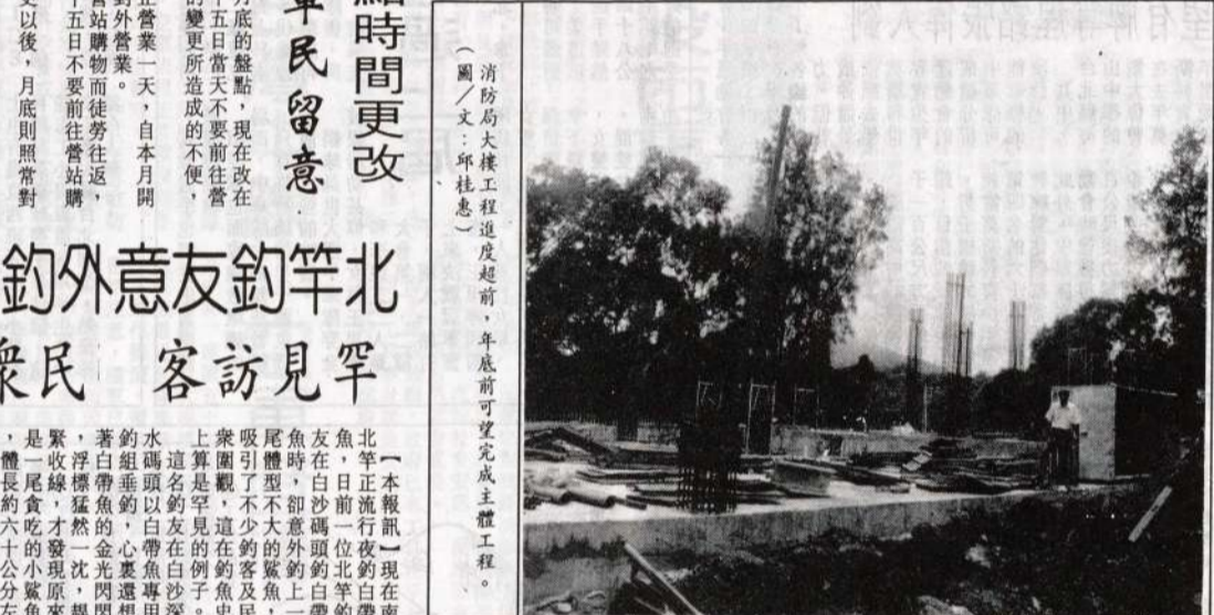
消防局大樓工程進度超前，年底可望完成主體工程。
