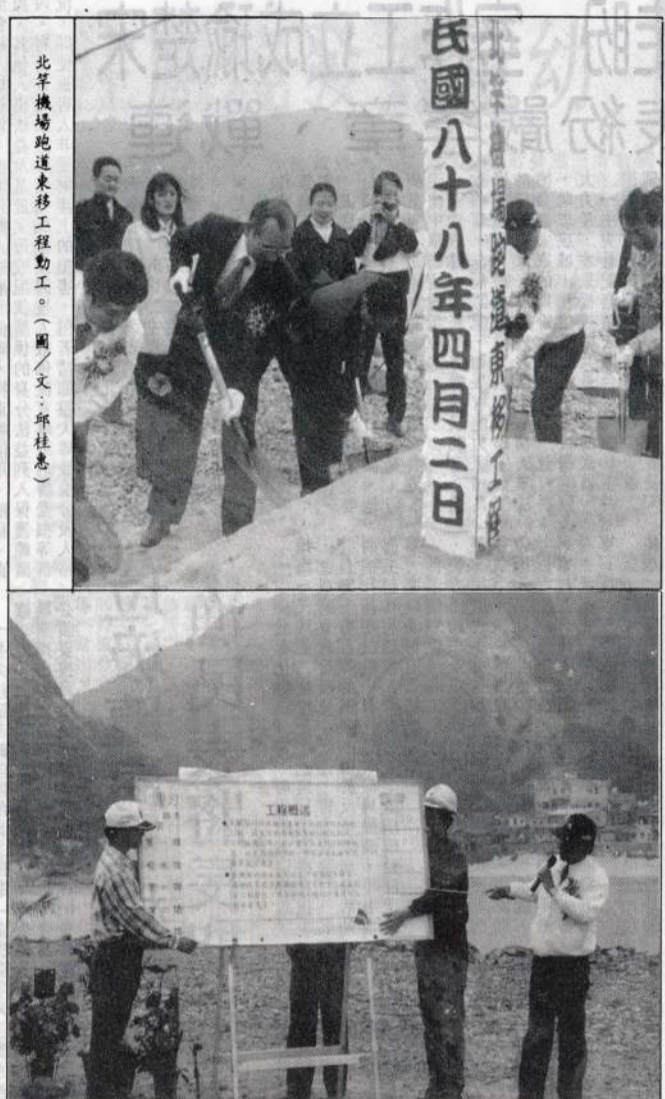
北竿機場跑道東移工程動工。(圖/文：邱桂忠)
