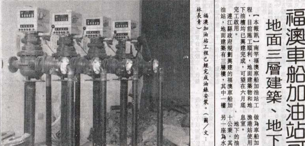
福澳加油站工程已完竣，圖為：(圖/文：林長青)
