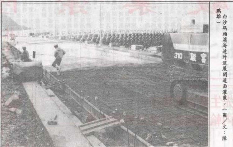
【本報訊】繼北竿板里道路開放通車之後，白沙連外道最開展後階段灌漿工程，全長八百米的灌漿工程，預定在五天左右可以完成。
