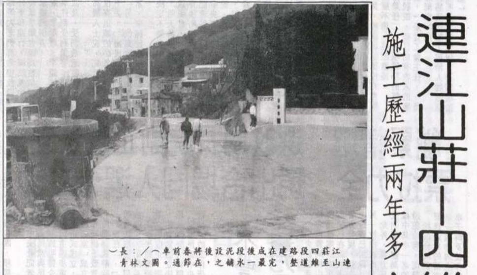
連江山莊至四維村全線道路春節前正式通車。圖為施工現場，工人正在進行最後的鋪設工作。
