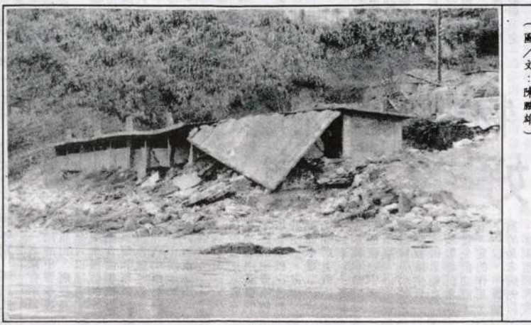
【本報訊】在經過海濱日侵月蝕之後，北竿後澳後港堤防的舊豬舍已經坍塌，邊坡土石鬆動形成危險區域，鄉公所表示，這塊區域已列入下年度重慶計畫，將配合地形興建公園，兼具景觀與保護功能。 北竿後澳後港堤防由於地勢低窪，後港舊豬舍附近因為長年海濱侵蝕，堤防基礎淘空，後港舊豬舍不僅在景觀上有影響，若不加以整治，可能危及整個後澳後港地區居民安全，地方已將這部分列入重慶計畫，未來要拆除舊豬舍，配合現有地形全面整治，有關經費將列入城鄉新風貌年度計畫中執行。 （圖／文：陳曉輝）
