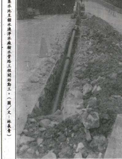
四維集水池至儲水潔淨水廠管路工程動工。(圖/文：林長青)
