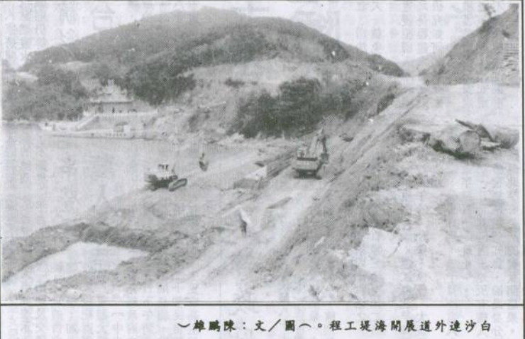
白沙碼頭連外道路工程現場
