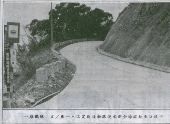
圖一：坂里垃圾場替代道路工程，目前進度已接近尾聲。
