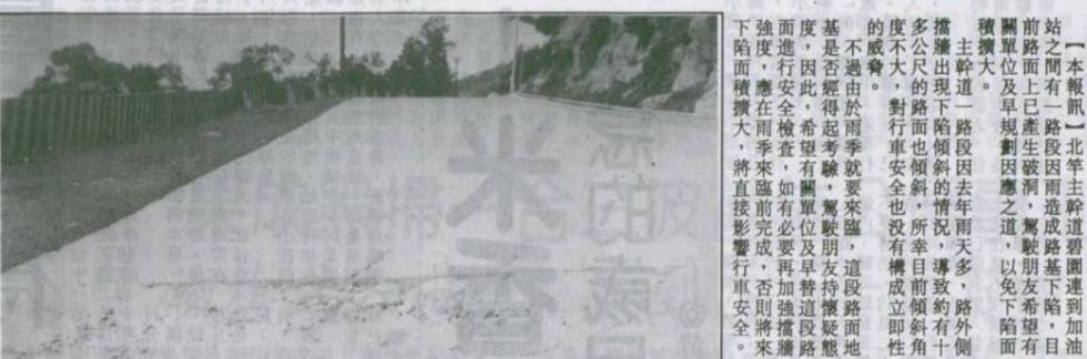
北竿主幹道碧園連到加油站路段下陷，路面出現多處坑洞，影響行車安全。
