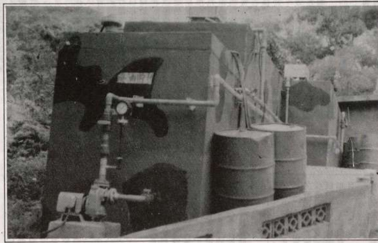
馬電興建完成的廢油處理槽。(圖/文：林長青)
