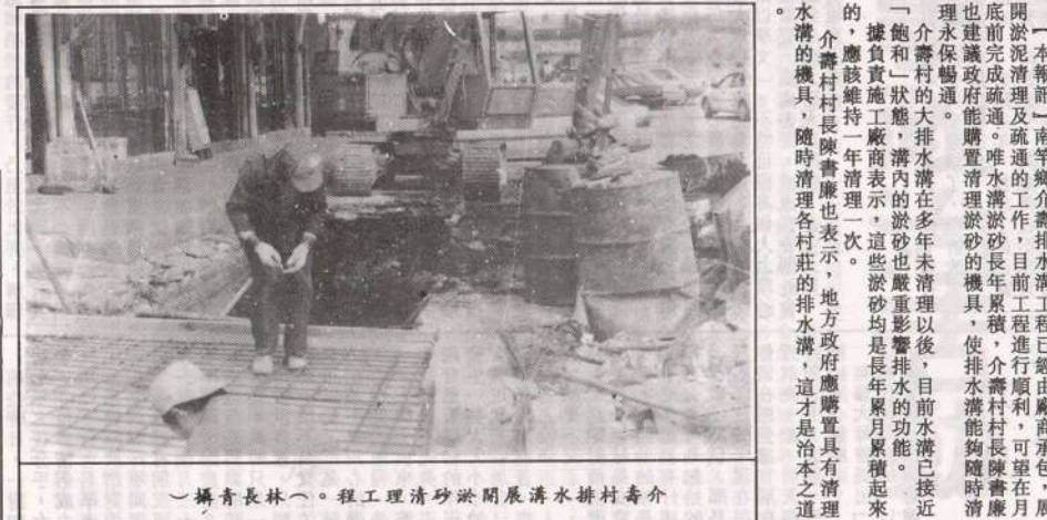
介壽村排水溝疏通工程。攝者林青。
