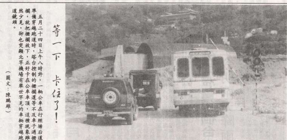
五月二十四日上午八時許，一輛公車在行經橋下後，準備過橋時，塔吊控制的橋樑等不及車子過橋，就把橋面放下，正好卡在公車車頂，這種現象雖然罕見，卻也突顯北竿機場有車世罕見的車輛穿地。
