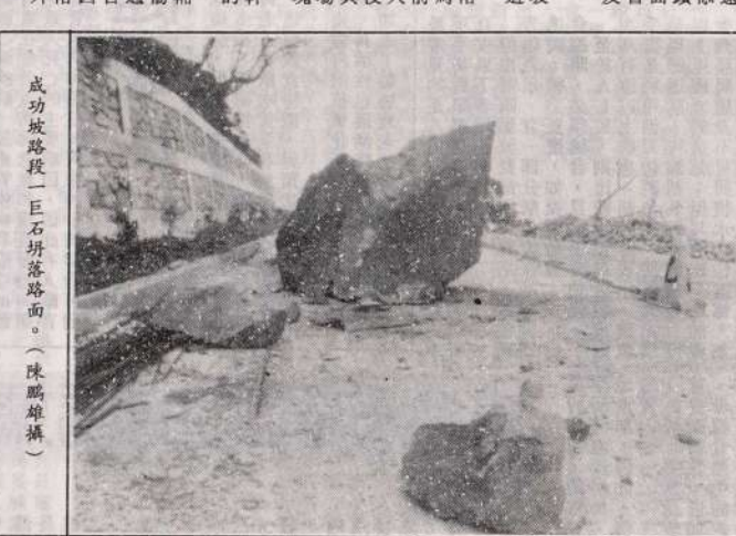
成功路段一段巨石崩塌，造成交通中斷。
