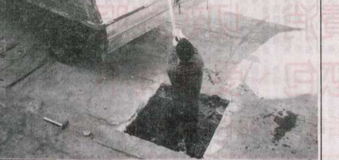
建設局派員補洞 介壽商場階梯恢復原貌
