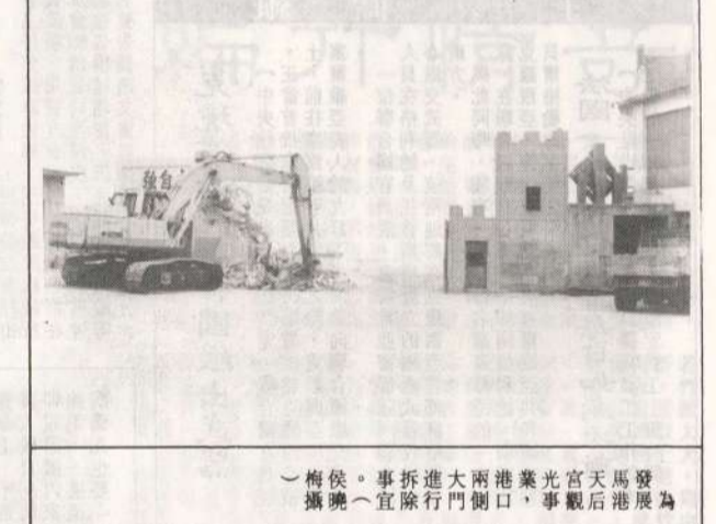
馬祖天后宮改建工程展開 拆除大門，進行拆除。
