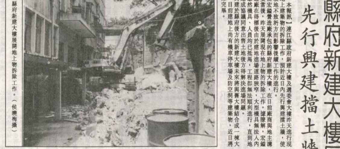
縣府新建大樓展開現地上建築物拆除工作。(侯曉梅攝)
