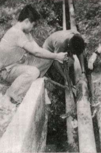
防區駐軍協助修復被損水管。（林長青攝）
