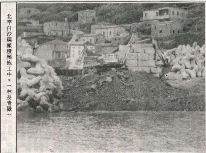
北竿白沙碼頭堆積極度施工中。(林長青攝)
