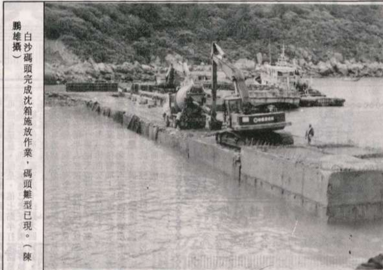
白沙碼頭完成沉箱施放作業，碼頭雛型已現。(陳鵬雄攝)
