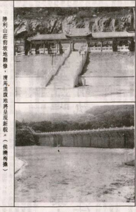
勝利山莊前坡地翻修，清馬道地將呈現新貌。(侯曉梅攝)
