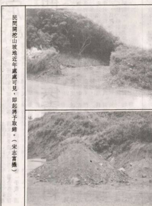
民間開挖山坡地近年處可見，即起將予取締。(宋志富攝)
