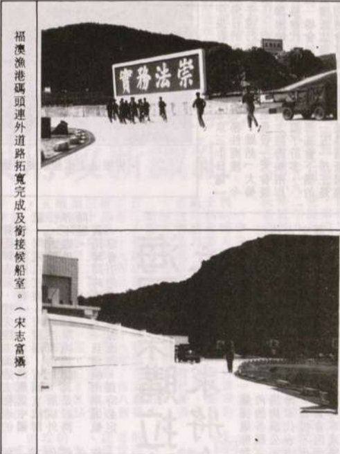
福澳漁港碼頭連外道路拓寬完成及銜接候船室。(宋志富攝)
