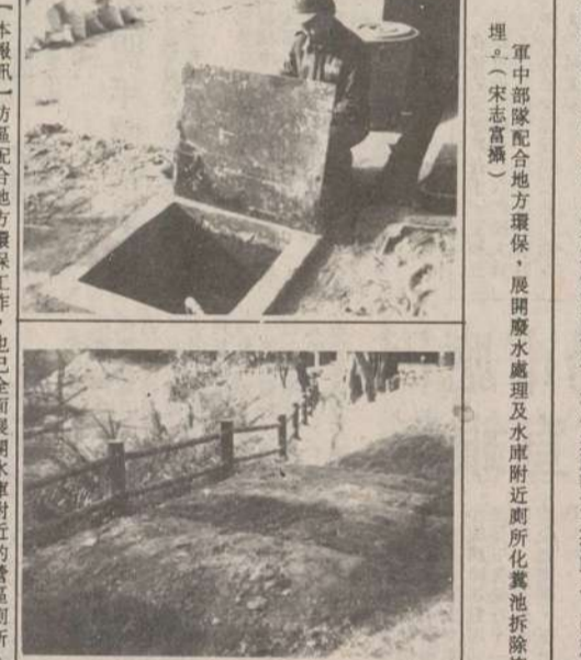
軍中部隊配合地方環保，展開廢水處理及水庫附近所化糞池拆除工程。
