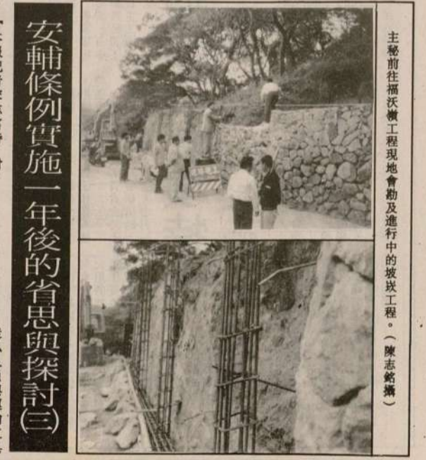
主秘前往福沃嶺工程現地勘測及進行中的坡坎工程。(陳志銘攝)
