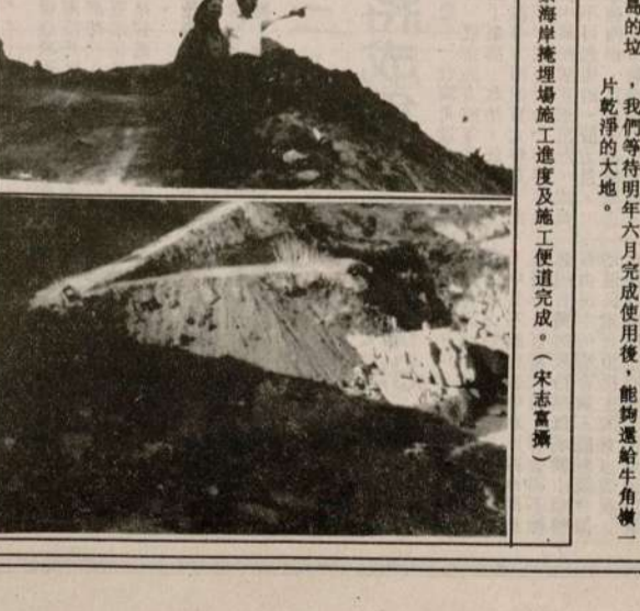
衛生局勘察海岸掩埋場施工进度及施工便道完成。(宋志富攝)
