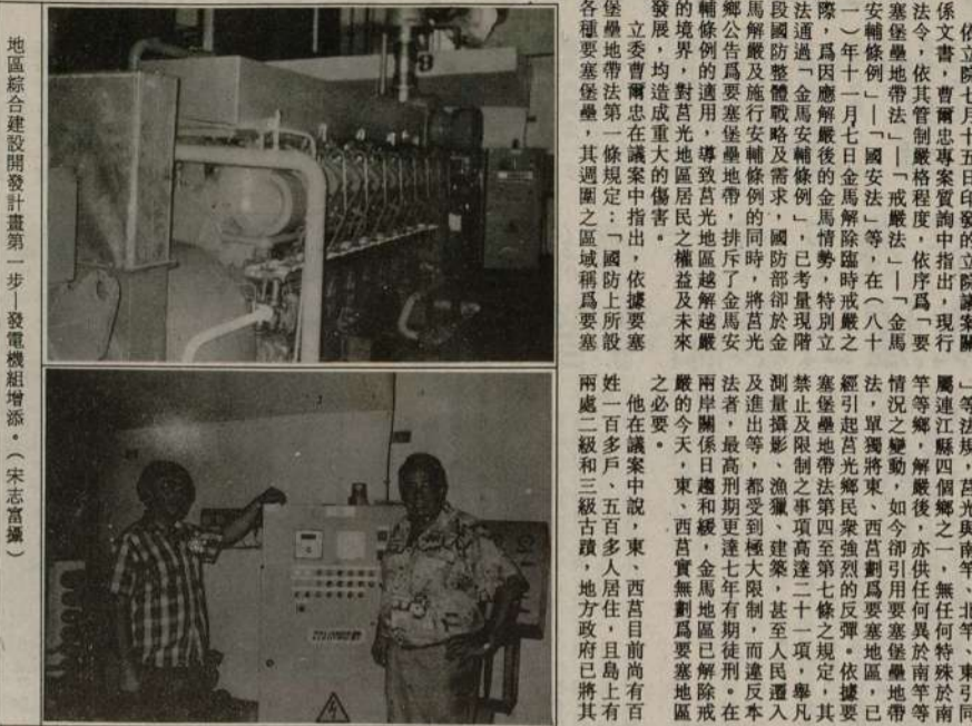
地區綜合建設開發計畫第一步：發電機組安裝。(宋志高攝)
