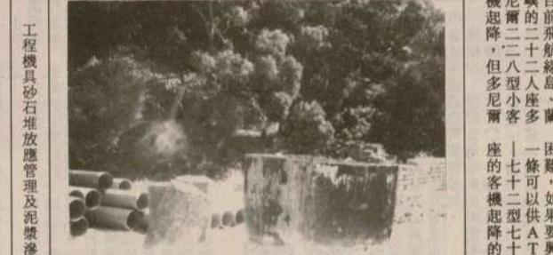
工程機具砂石堆放應管理及泥漿渣落地面結塊。(志富攝)
