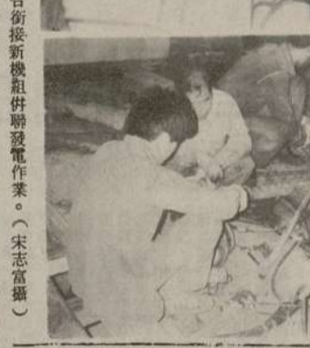
志清電廠更換原有機組零件及配合新機組併聯發電。
