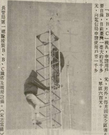
長官局第一總隊按裝B、C鐵塔及機房設備。(宋志富攝)
